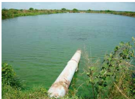
Fotografía 1: Laguna de tratamiento
