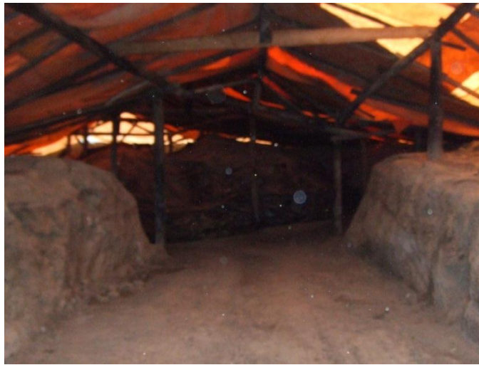
Figuras 5 y 6. Modelo de techo provisional
